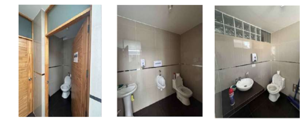
En las imágenes se visualiza los baños del primer y segundo piso en buen estado los inodoros y lavamanos. Asimismo las paredes y pisos no cuenta con SS.HH. para discapacitados
