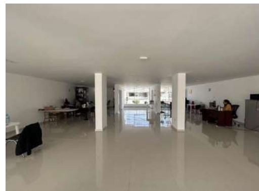
Una vista interior del segundo piso, se observa el buen estado del piso y las paredes.
