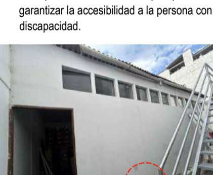
Se demolerá los sobrecimientos y la pared de drywall.
