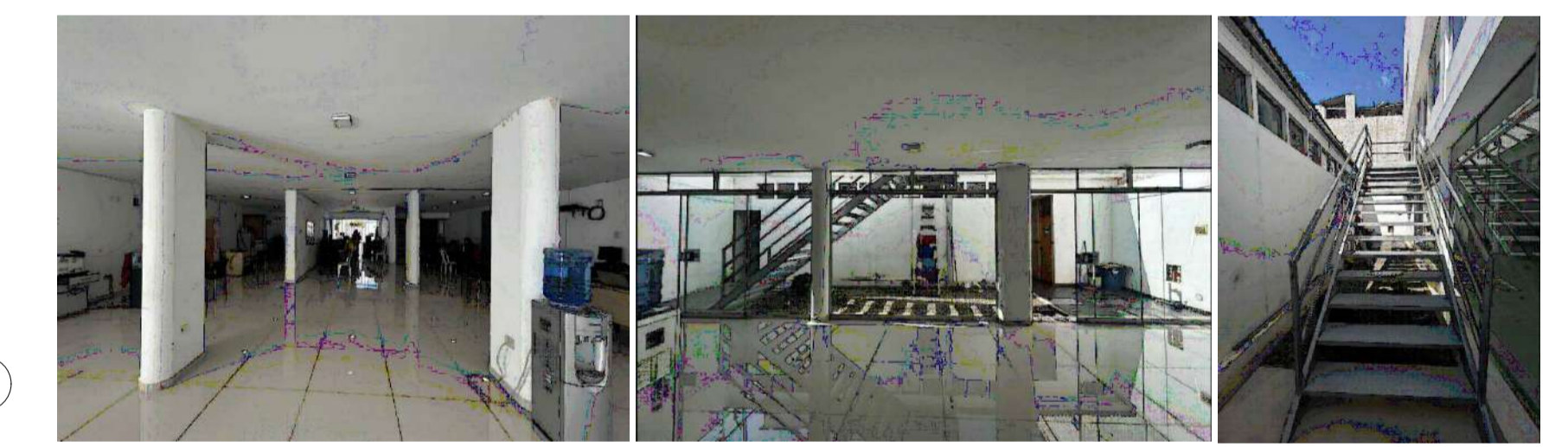
Una vista interior del primer piso, se observa el buen estado del piso y las paredes. Una vista interior del primer piso, se observa la mamparas. Las imágenes muestran los accesos verticales que conectan el primer piso con el segundo piso, siendo uno de estructura metálica y la otra de concreto armado.
