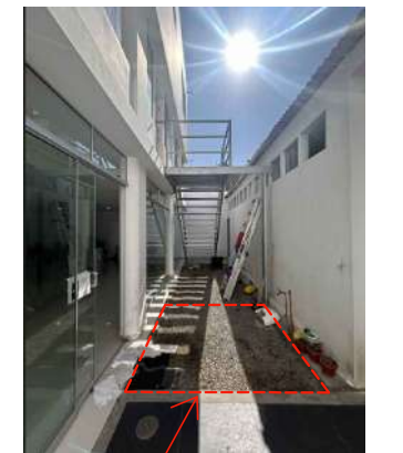
Se implementa un vaciado el piso para garantizar la accesibilidad a la persona con discapacidad.
