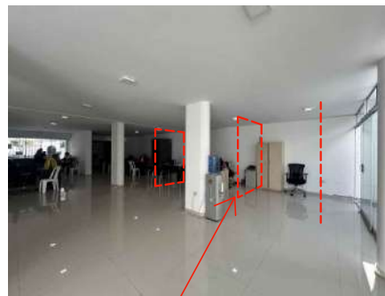
Esta área se intervendrá con separaciones de vidrio templado de 10mm.
