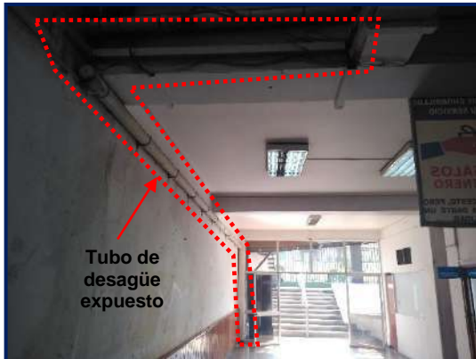
Tubos de desagüe de PVC-SAP Ø 4" expuestos.
