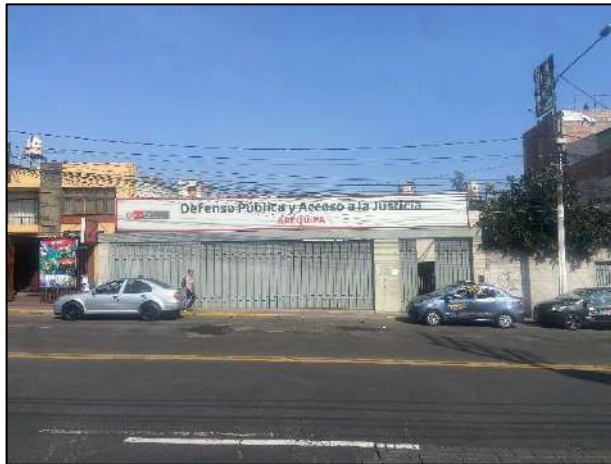
Foto 2.- Vista de fachada de ingreso del proyecto.
