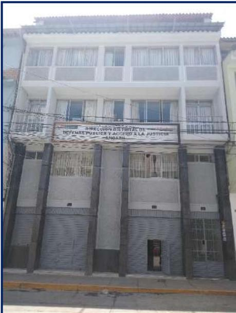
Vista de la fachada de la edificación de cinco (05) pisos, infraestructura de albañilería confinada con columnas y vigas de concreto, puerta metálica enrollable pintura deteriorada.
