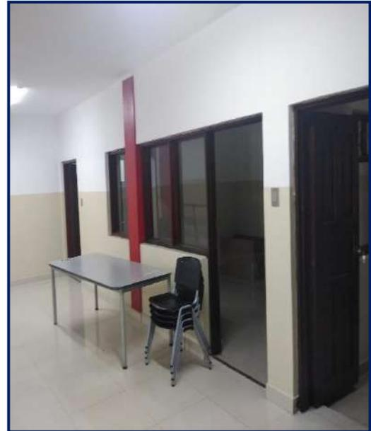
Vista puerta derecha acceso al patio intermedio, puerta central acceso a ambiente con S.H. integrado, puerta del lado izquierdo conecta a corredor, los vidrios de las ventanas sin lámina de protección, pintura en paredes manchadas.
