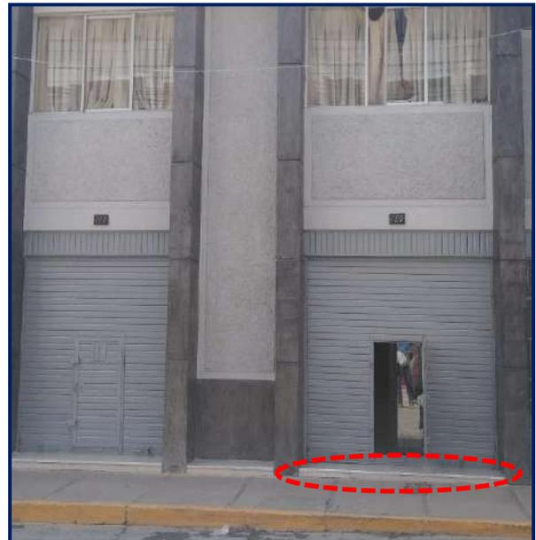
Vista acceso al primer piso con desnivel de 10 cm. Desde la vereda, fachada pintura deteriorada.
