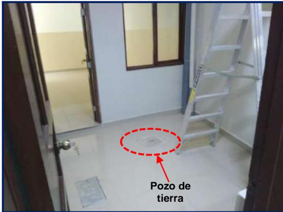
Vista del patio intermedio en donde podemos notar la caja de registro de desagüe y la tapa del pozo de tierra, pintura en paredes manchadas.
