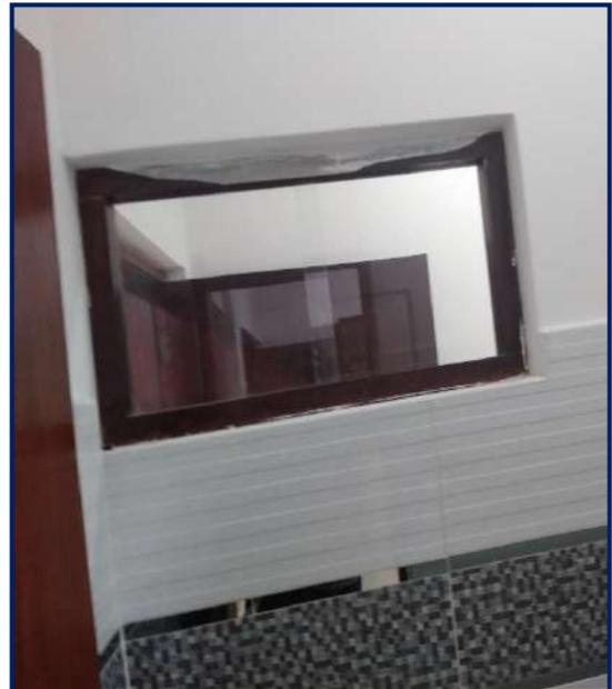
Vista del S.H. integrada a un ambiente, ventana con vidrio fijo sin ventilación natural ni mecánica.
