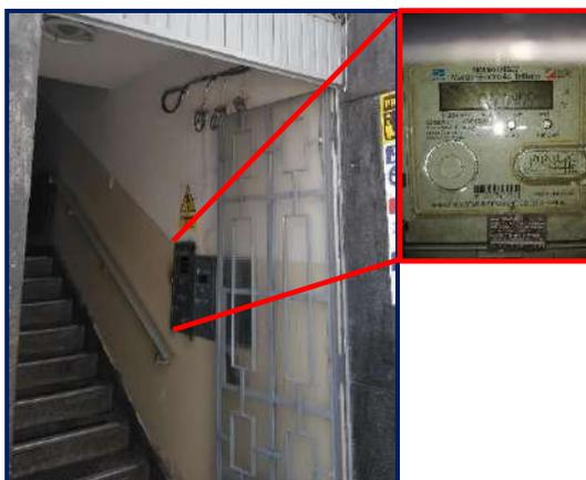
Vista del banco de medidores ubicado en el Hall de acceso a los pisos superiores, el medidor de energía eléctrica para el primer piso es trifásico.
