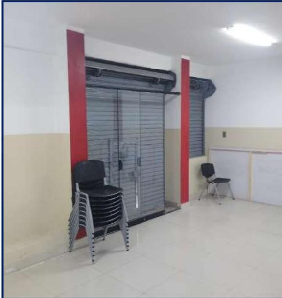
Vista desde el interior de la puerta del segundo acceso con puerta metálica enrollable y puerta mampara corrediza a media altura, pintura en paredes manchadas y luminaria inadecuada para oficinas.
