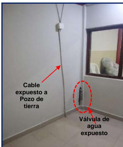
Vista del patio intermedio, cable de conexión a pozo de tierra expuesto, válvula de agua expuesto.
