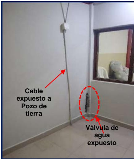
Vista del patio intermedio, cable de conexión a pozo de tierra expuesto, válvula de agua expuesto.
