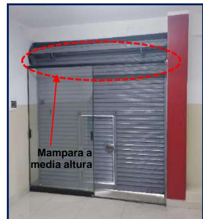
Vista del ingreso al primer piso desde el interior, mampara a media altura insuficiente para el control de confort en la parte de climatización
