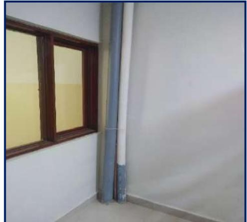
Vista de las tuberías montantes de desagüe de sólidos de los pisos superiores el tubo blanco montante de desagüe pluvial y detrás de ellos las tuberías de agua fría y un tubo para agua caliente sin uso. Tuberías expuestas.
