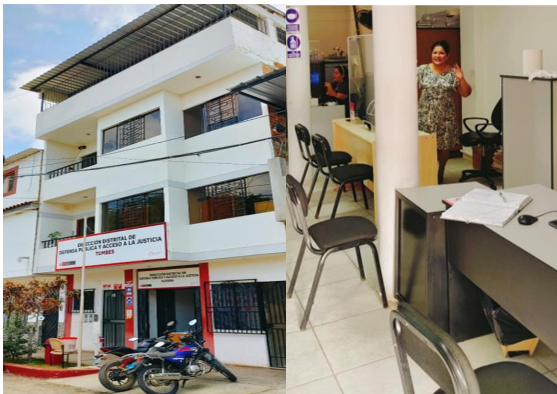
Figura 01: Imágenes de la infraestructura existente de la sede ALEGRA Tumbes
