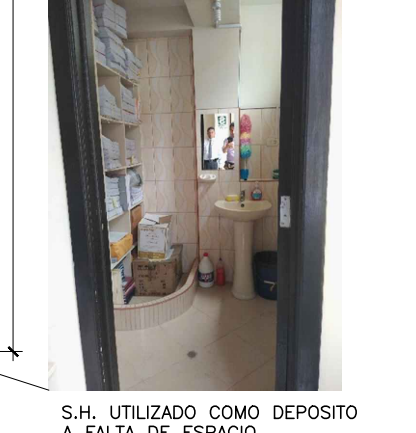
S.H. UTILIZADO COMO DEPOSITO A FALTA DE ESPACIO.
