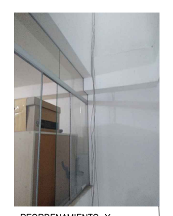
REORDENAMIENTO Y CANALIZACION DE LOS CABLES EXPUSTOS.
