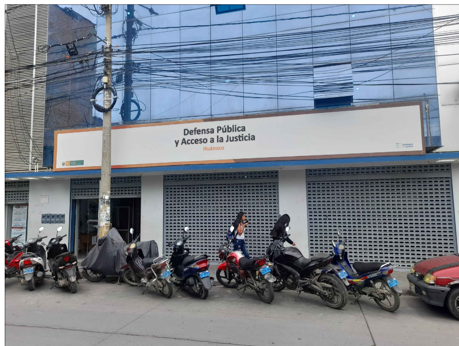
FOTOGRAFIA 14: DETALLE DE FACHADA
