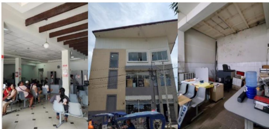
Fotografías de la infraestructura existente de la sede ALEGRA Maynas.
