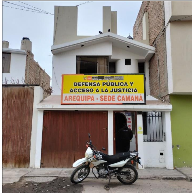
Foto 3.- Vista frontal del área del proyecto en la entrega de terreno.
