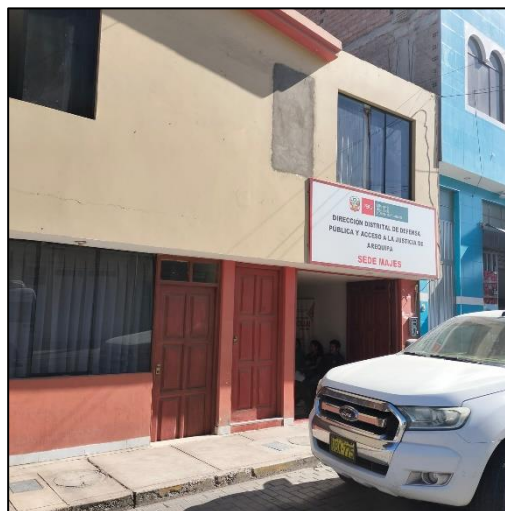
Foto 1.- Vista del entorno del Centro Alegre Majes
