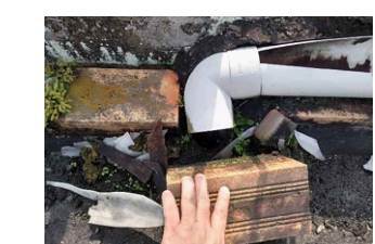
TECHO DE AZOTEA: DRENAJE PLUVIAL Y CONEXION DE CANALETA QUE VIENE DE LA COBERTURA LAMINA DE CALAMINA ONDULADA DE ZINC.
