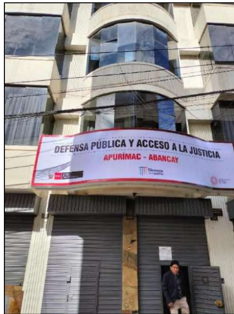
Foto 3.- Vista frontal del área del proyecto en la entrega de terreno.
